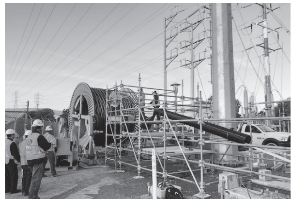
写真6 ケーブル布設
