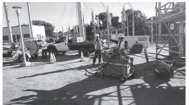
写真9 光ケーブル布設
