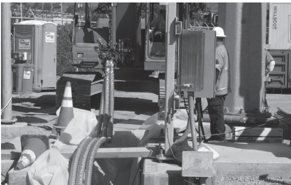
写真4 既設ケーブル撤去
