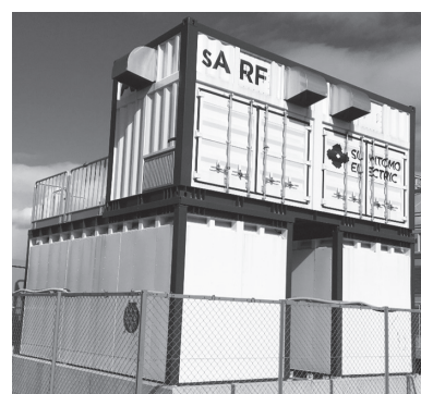
写真2 コンテナ型RF電池システム例
