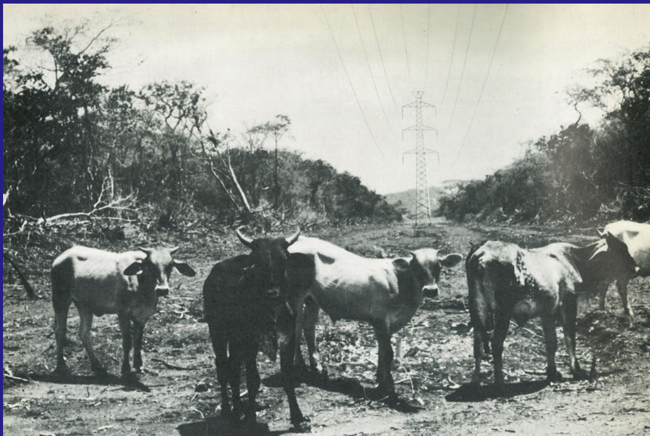
完成したベネズエラのカロニー送電線
