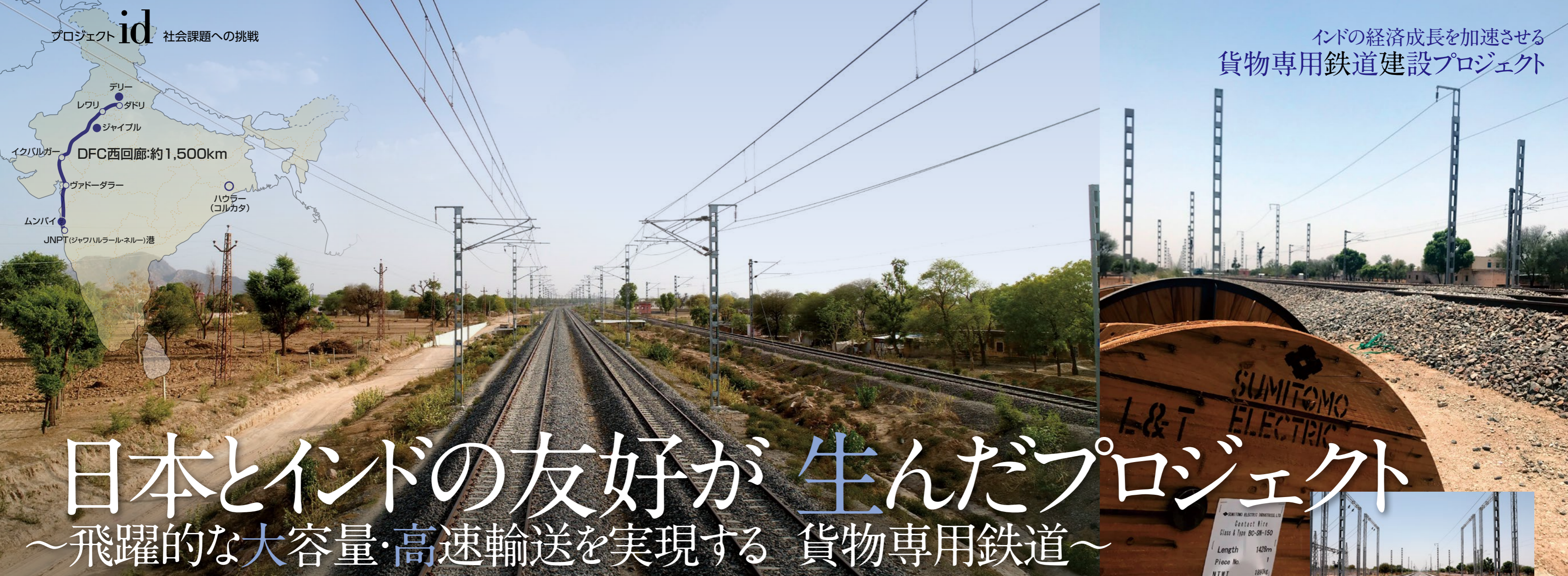
トオリ線が張られたDFC西回廊の貨物専用鉄道(ジャイプル近郊)
