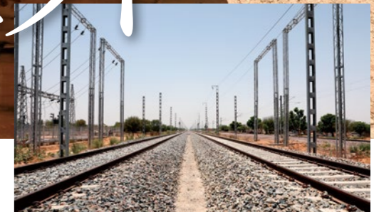
トオリ線の架線工事前の鉄道。レールに沿って整然と電柱が並んでいく
