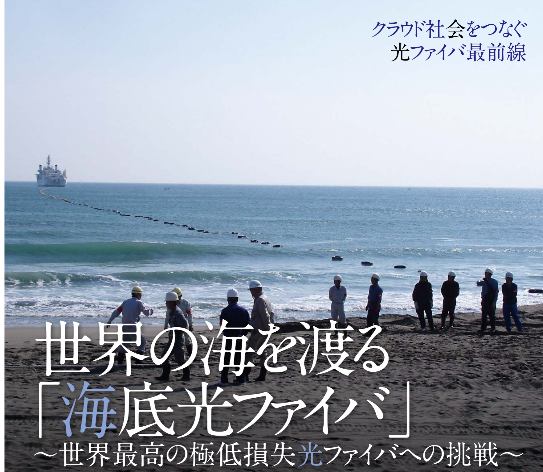
海底ケーブル敷設の様子 (写真提供: 日本電気株式会社)
