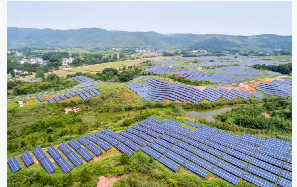
広域で多くのパネルが稼働する太陽光発電所では異常箇所を検知することが難しい。
