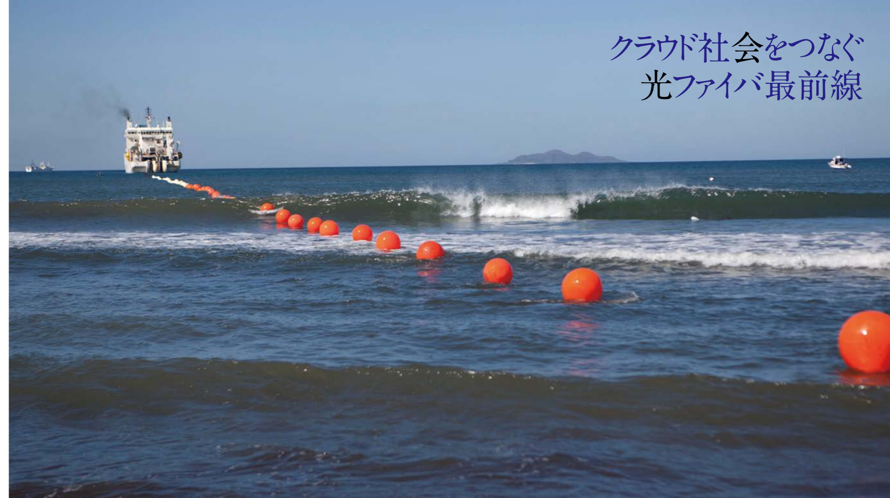
海底ケーブルの敷設（写真提供：日本電気株式会社）
