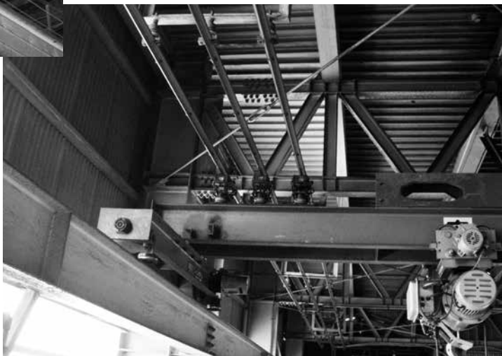
側面水平下向き布設例
