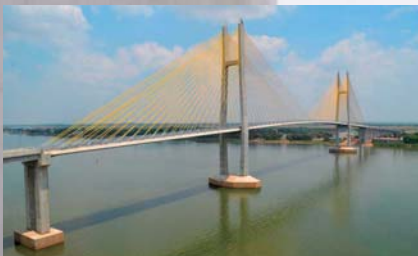
つばさ橋（カンボジア、南部経済回廊）※1 斜張橋
