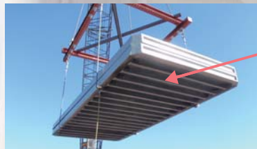
東京国際空港D滑走路（東京都）※2 超高強度繊維補強コンクリート（サクセム）床版
