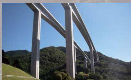
佐奈川橋（仮称）（愛知県、新東名高速道路）※3
