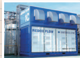
レドックスフロー電池
