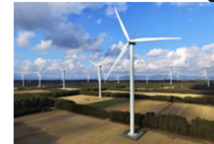
写真提供: (株)グリーンパワーインベストメント
